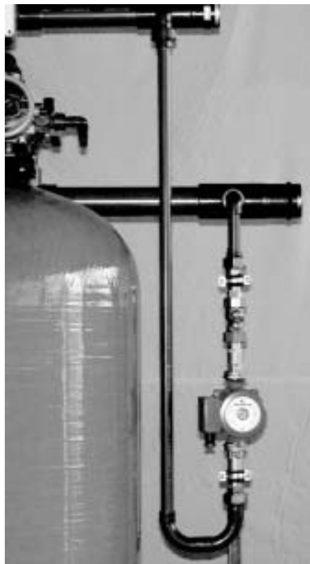
Vodní recirkulace WUP-D 8 na změkčovacím zařízení Sensotrol 800.
